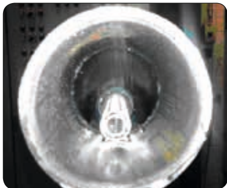
Sensoren monteret i bøjningen. Sensoren skal monteres ned mod bunden af røret da kølemidlet/gassen har et to-fase forløb.
