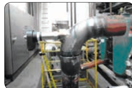
Rørinstallationen under opsvejsning. HBCP er monteret i bøjningen.
